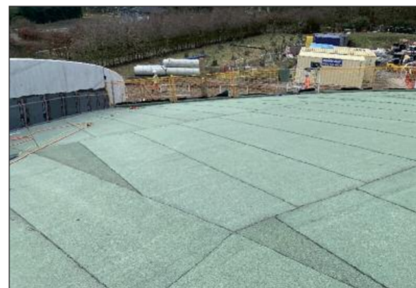
Zweite Abdichtungslage BauderPLANT E mit integriertem Durchwurzelungsschutz.
