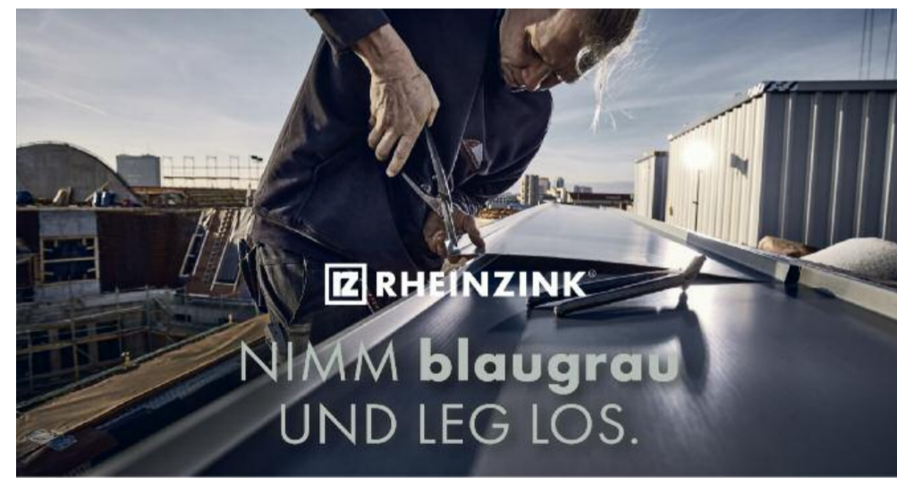
Handwerklich präzise: Beim Falzen wird jede Schar sorgfältig geformt und fixiert, damit die Verbindung flexibel und witterungsbeständig bleibt.
