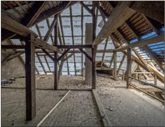
Der Dachraum vor der Sanierung.
